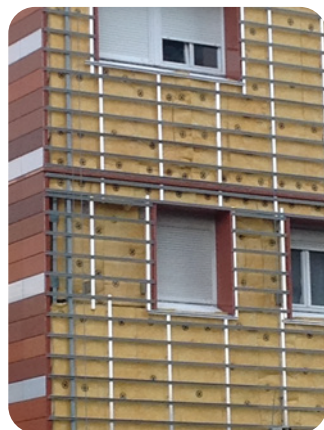
Aislación continua por detrás de la estructura.
