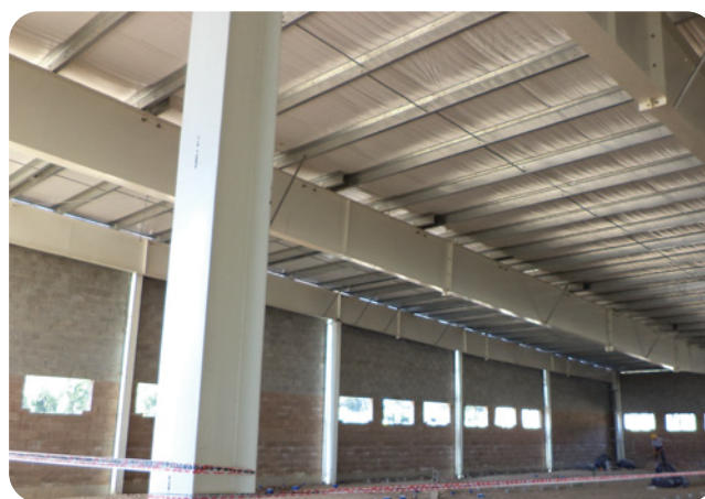
Utilización del FielTRO Tensado en cubiertas nuevas.
