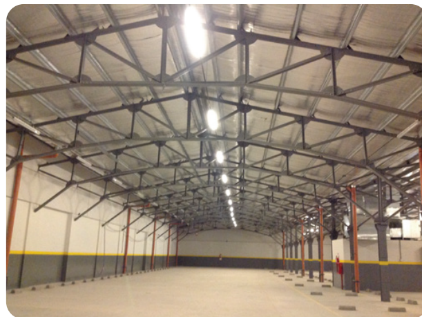
Fieltro tensado Alu colocado sobre malla plástica.
