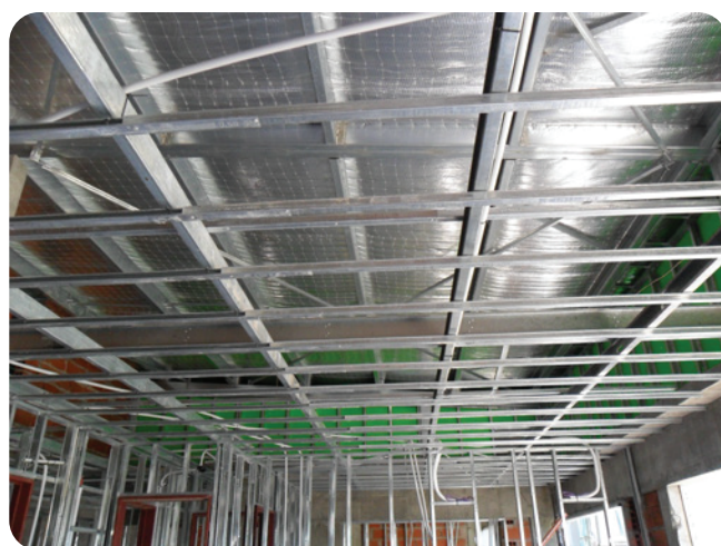
Utilización Filtro Tensado Alu en cubierta.
