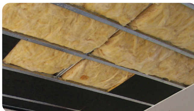
Aislamiento por el interior sobre cielorraso.
