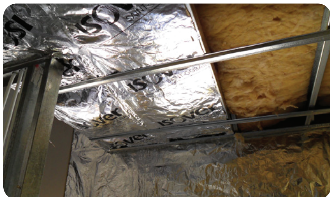
Utilización del Filtro Liviano como espesor complementario, sobre Rolac Plata.
