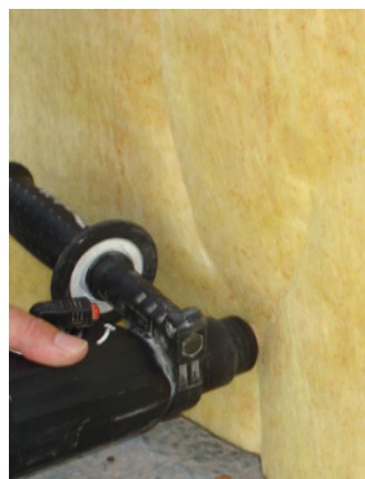
1. Perforar para instalar la fijación.
