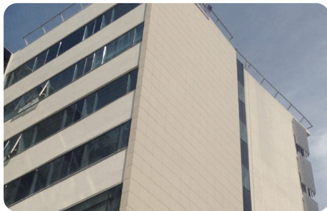
Instalación Panel Fachada con velo negro con revestimiento de porcelanato.
