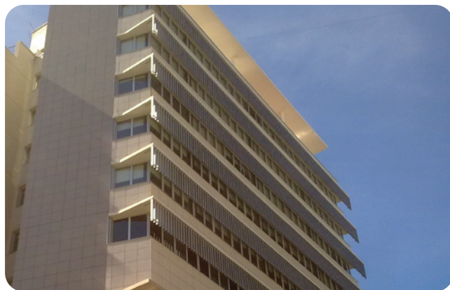
Instalación Panel Fachada con velo negro con revestimiento de porcelanato.
