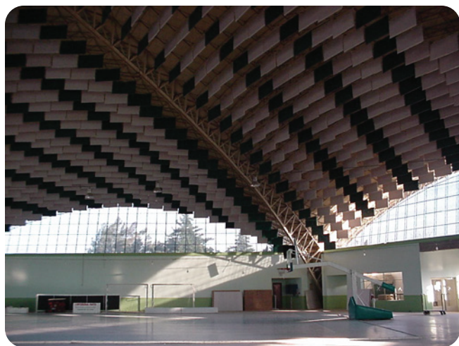
Utilización de andina Isocustic como baffles (2 paneles/baffle).
