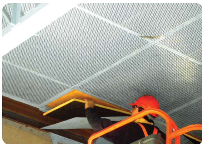
Utilización de Andina Isocustic detrás de bandejas perforadas.
