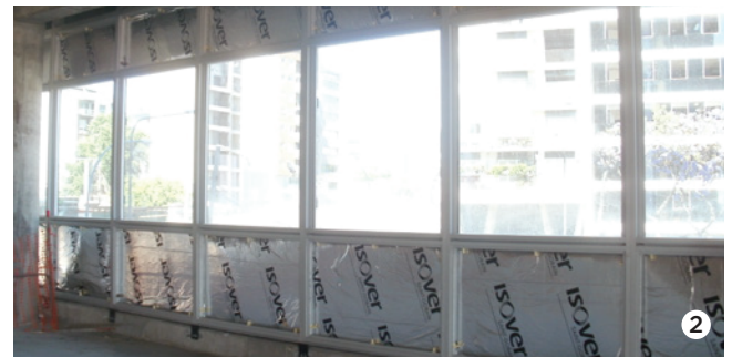
2. Montaje del módulo en obra.
